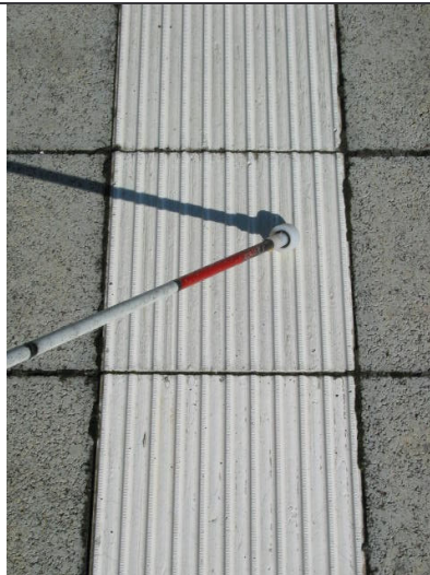
Abb. 12 b: Rippenstruktur 30/2,5 mm Leitfunktion: 2,48 Aufmerksamkeitsf.: 3,15 Füße: 5,70
