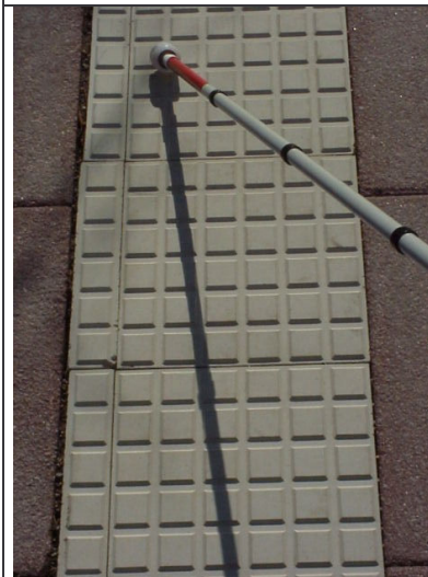
Abb. 13 i: Waffelstruktur (Leipzig) 13 mm (=Rillenbreite)/3mm Aufmerksamkeitsf.: 4,31
