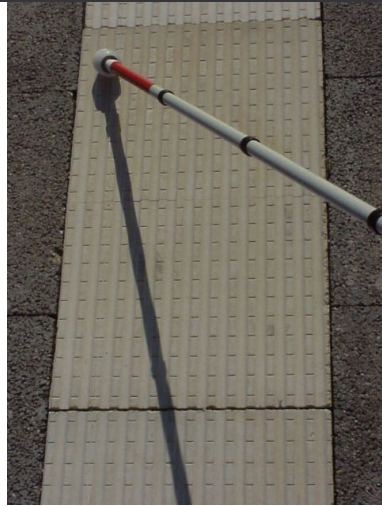
Abb. 13 e: Flachrillen-Struktur (Leipzig) 20/3 mm Leitfunktion: 3,61 FüÙe: 6,00
