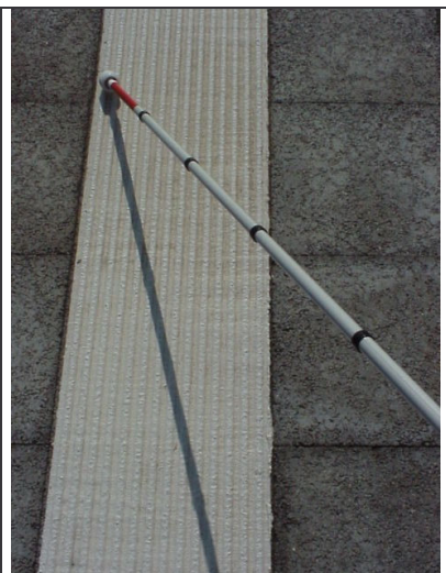
Abb. 13 c: Rippenstruktur/Kaltplastik (Böblingen) 20/3,5 mm Leitfunktion: 3,30 Aufmerksamkeitsf.: 3,87 FüÙe: 5,78
