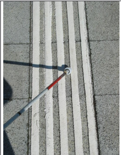
Abb. 12 c: Streifen- Struktur/Kaltplastik (Öster- reich) 60/4,5 mm Leitfunktion: 2,48 Aufmerksamkeitsf.: 2,82 Füße: 3,19
