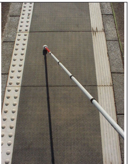
Abb. 12 f: Führungsweg (Gummifläche mit Steinrand; Marburg) Leitfunktion: 2,75 Aufmerksamkeitsf.: 2,65 (gute Ergebnisse mit Keramikspit- zen, knapp befriedigende mit Rollspitzen) Füße: 6,00
