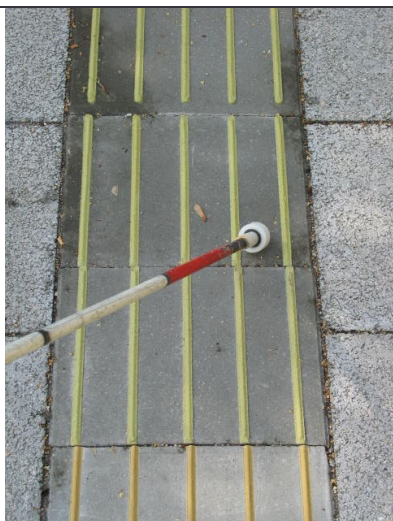
Abb. 13 b: Farbrippen (Niederlande) 60/3 mm; Leitfunktion: 3,17; FüÙe: 3,22
