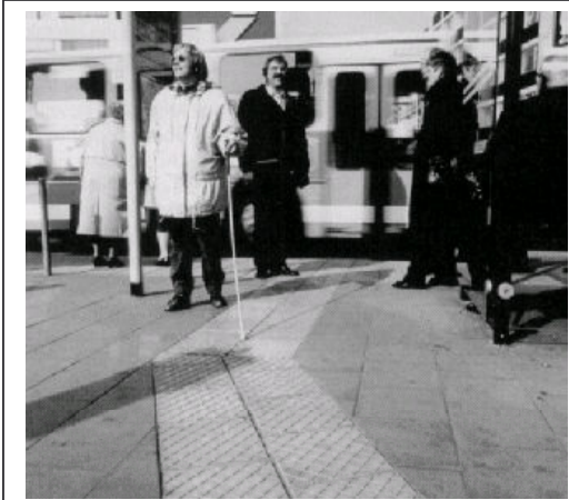
Abb. 3: Die „Orientierungsplatte“ aus Münster/Westfalen belegte mit deutlichem Abstand zu den übrigen Strukturen den letzten Rangplatz - von vielen Testpersonen wurde sie überhaupt nicht wahrgenommen. Sie ist als ungeeignet abzulehnen. (Abbildung entnommen aus „direkt“ Nr. 54, s. Anm. 4)
