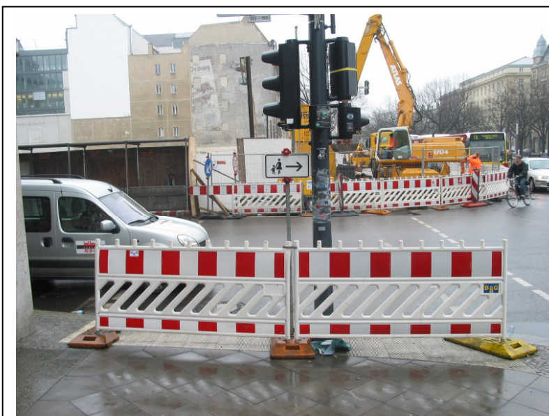
Abb. 4: Kann der gegenüberliegende Gehweg nicht betreten werden, muss eine Abschränkung das Queren von Fußgängern verhindern.
